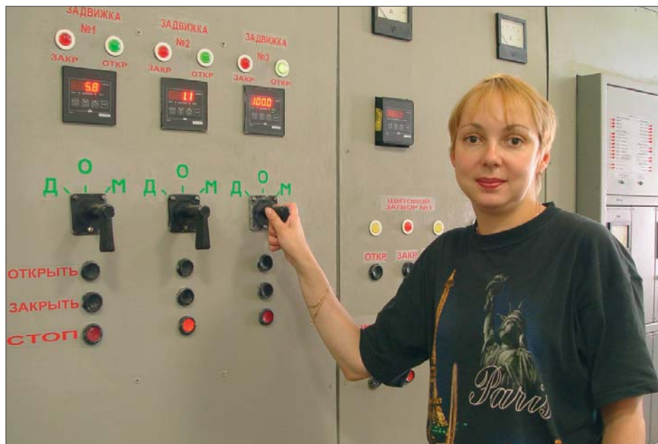
Фото 2. Саввинская насосная станция. Пульт управления задвижками. Хорошо видна степень их открытости: задвижка №1 – 5,8%, задвижка №2 – 1,1%, задвижка №3 – 100,0%
